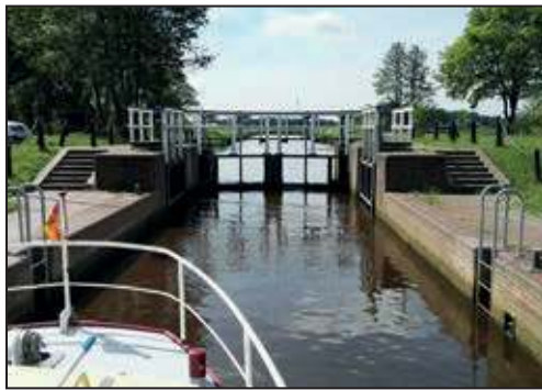
Schleuse in Ostrhauderfehn
