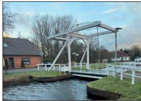
Klappbrücke Weers in Ostrhauderfehn, links das alte Verlaatshus (Schleusenhaus)
